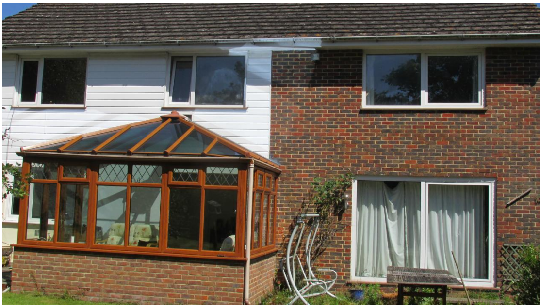
Rear patio door
